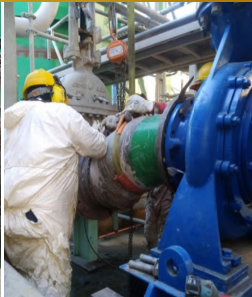
Imagen 12. Montaje Bomba 14 Planta CPF.
